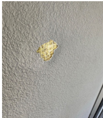
Schäden an der Fassade durch Steine, die im Rasen liegen und durch den Rasenmäher zu Geschossen werden.
