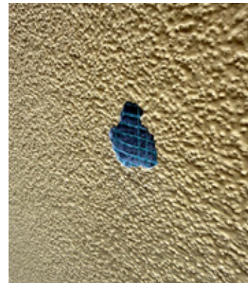
Schäden an der Fassade durch Steine, die im Rasen liegen und durch den Rasenmäher zu Geschossen werden.
